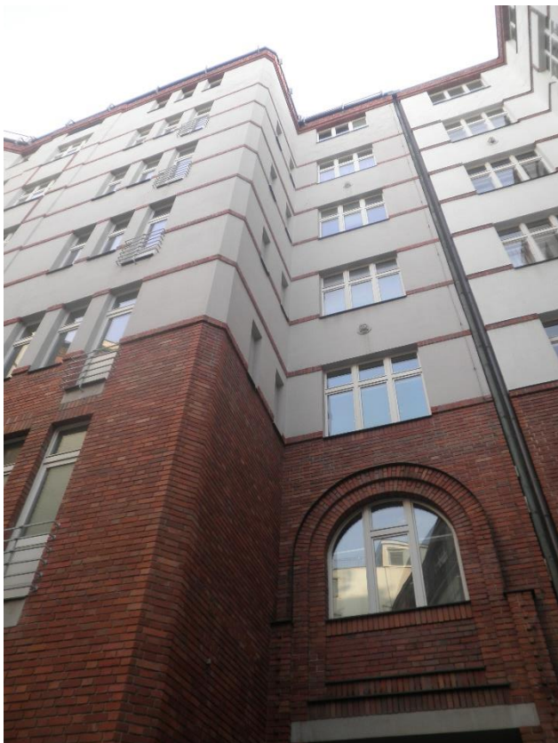
Východní pohled na Administrativní budovu ze dvora
