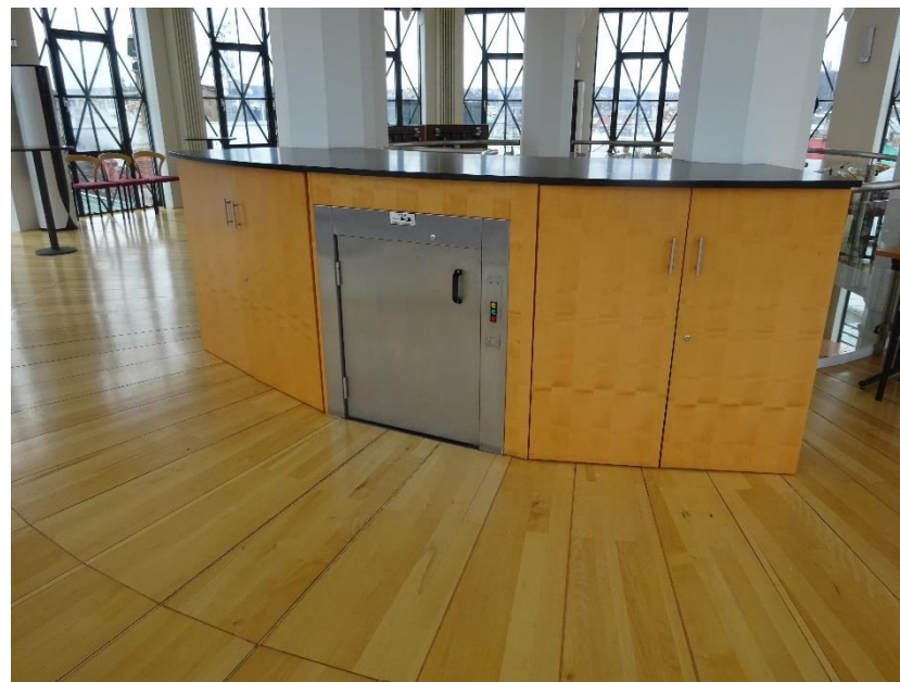
Interiér kupole (horní podlaží) – zásobovací výtah
