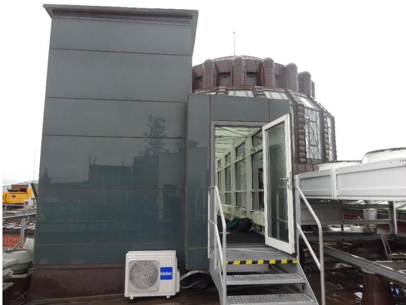
Spojovací chodba mezi hlavními výtahy a kupolí
