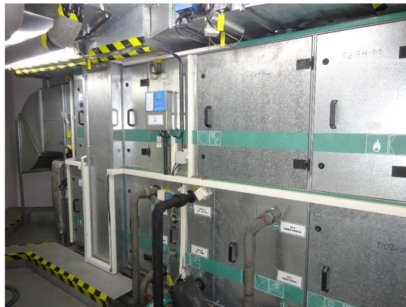
Interiér kupole (spodní podlaží) – zázemí VZT pro 7.NP a kupoli
