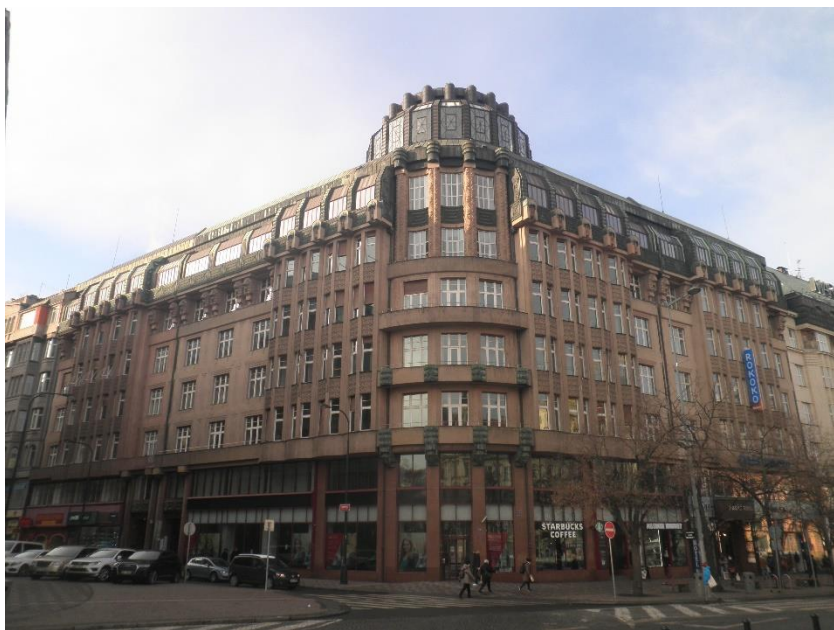
Západní pohled na Administrativní budovu z Václavského náměstí
