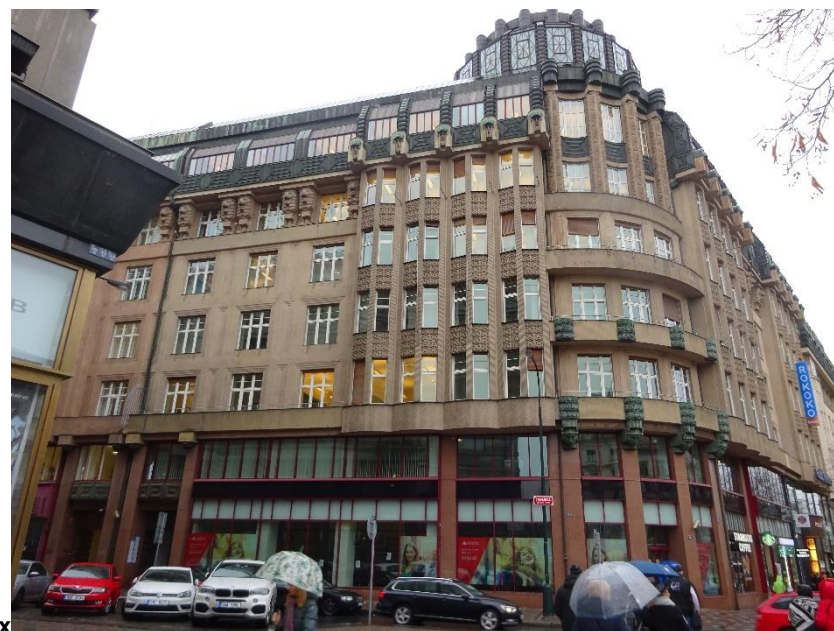
Jihozápadní pohled na Administrativní budovu z Václavského náměstí
