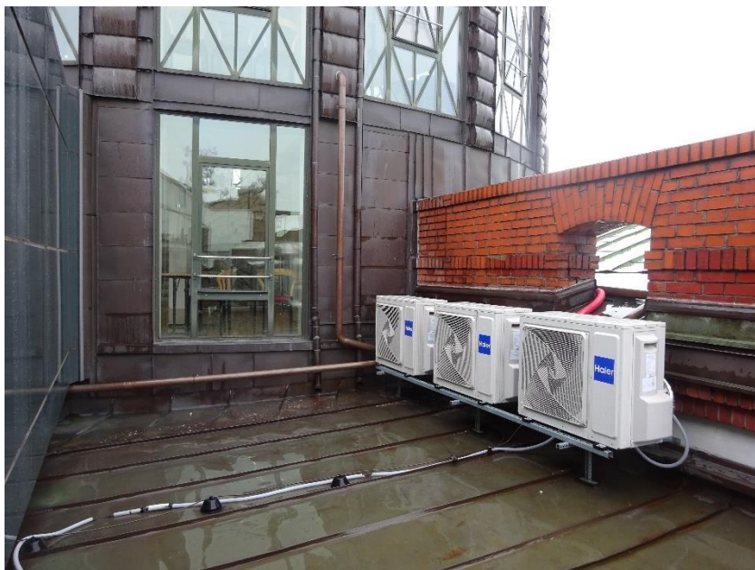
Zastřešení Administrativní budova
