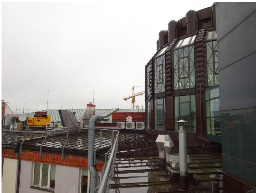
Zastřešení Administrativní budova
