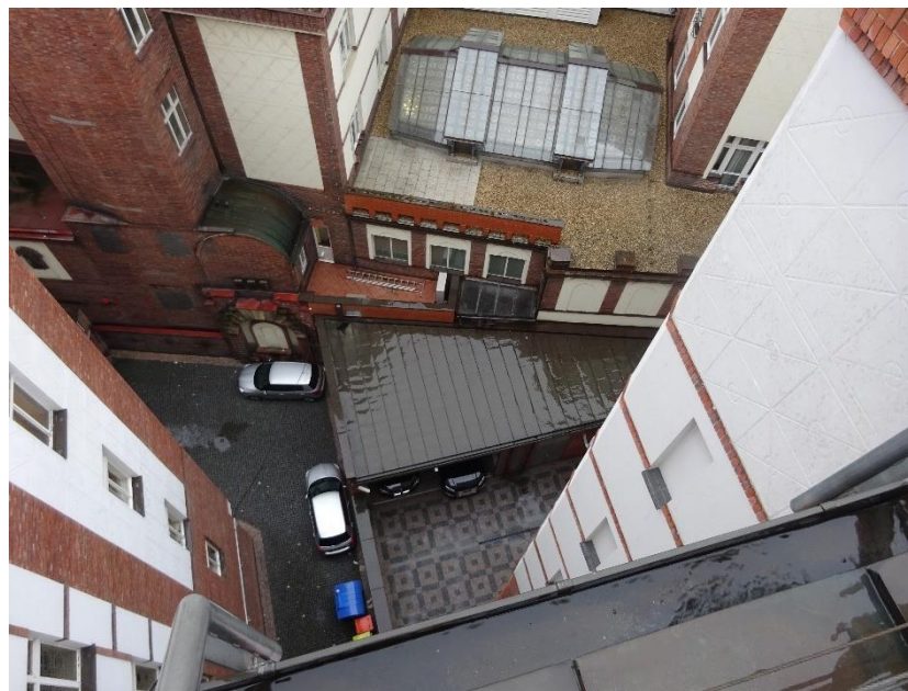
Zastřešení Administrativní budova
