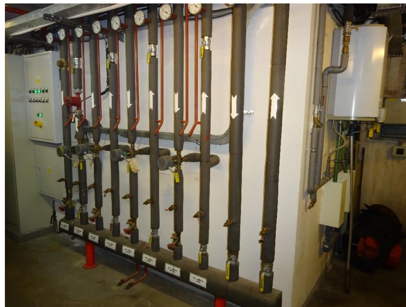
Suterén Administrativní budovy – technické zázemí
