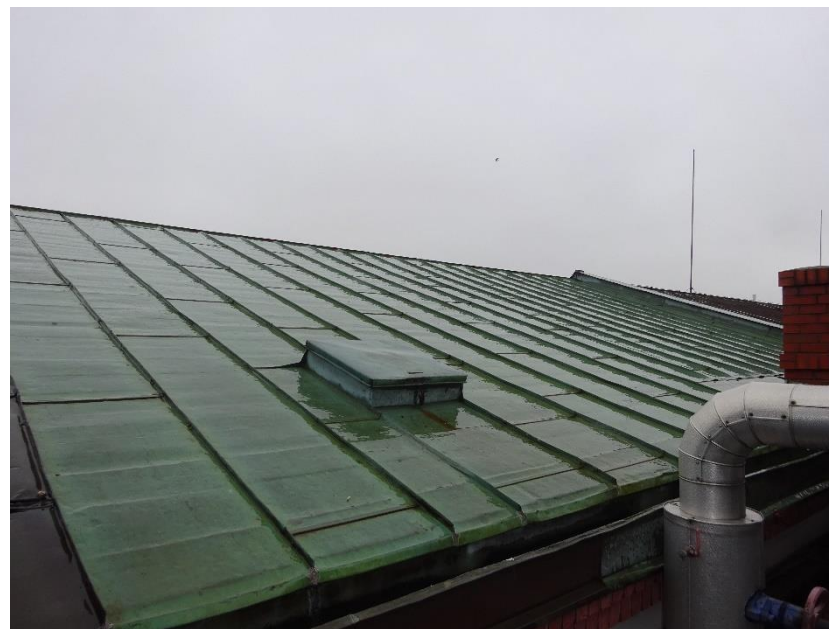
Zastřešení Administrativní budova
