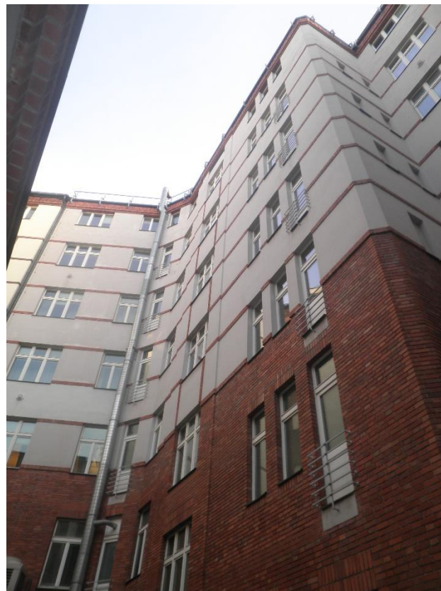
Jižní pohled na Administrativní budovu ze dvora
