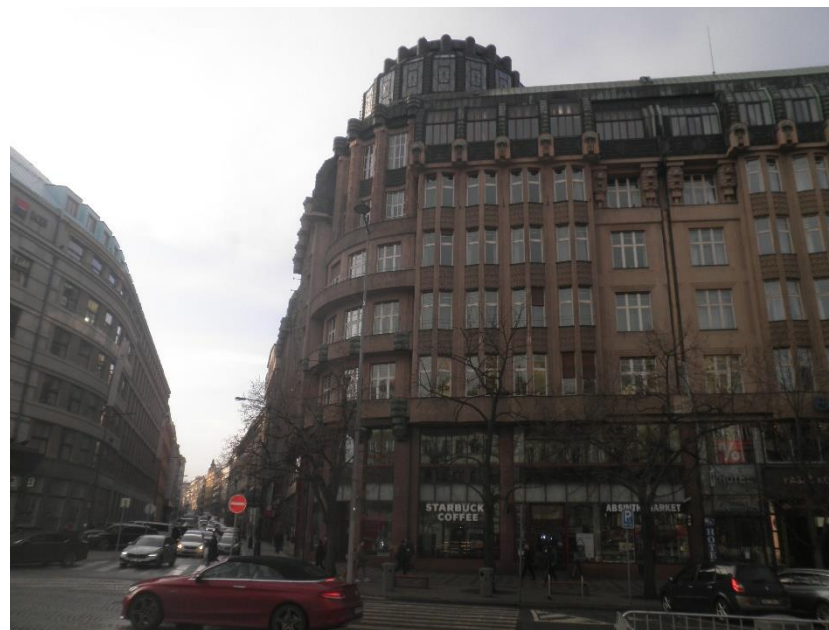
Severozápadní pohled na Administrativní budovu z Václavského náměstí
