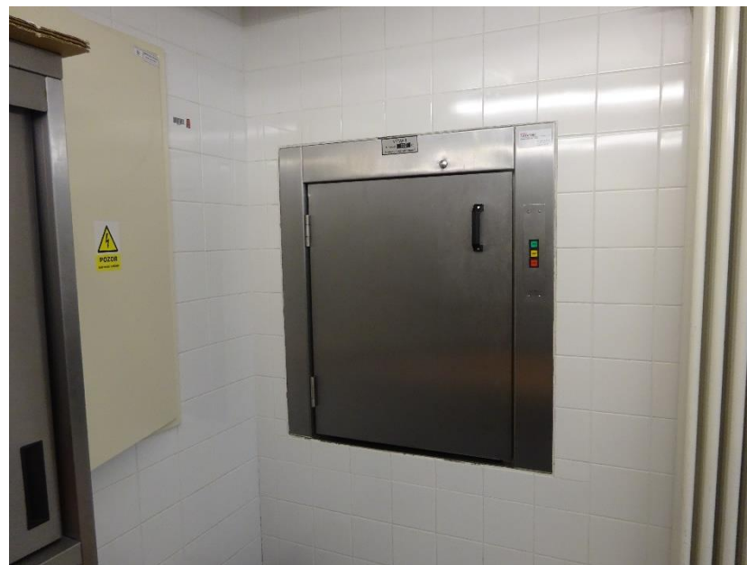
Interiér kupole (spodní podlaží) – kuchyně (zásobovací výtah)
